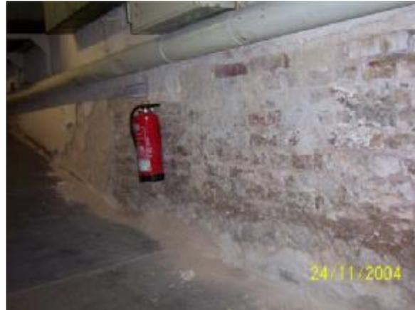
**Problemstellung:** Sehr starke Schädigung der Bausubstanz. Der Putz ist durch die Feuchtigkeit und das damit verbundene Salz komplett zerstört. Das Mauerwerk ist zum großen Teil vom Salz zerfressen.
