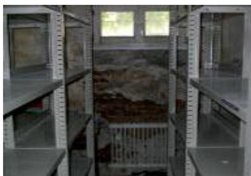
**Ausgangszustand:** Extrem starke Putzzerstörung und muffiger Geruch im Kellerbereich.
