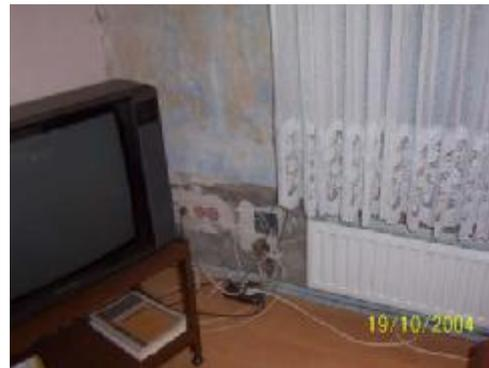
Problemstellung: Extrem starke Putzerstörung und muffiger Geruch im Wohnbereich. Teilweise Bindemittelzerstörung des Sockels im Innen- und Außenbereich.
