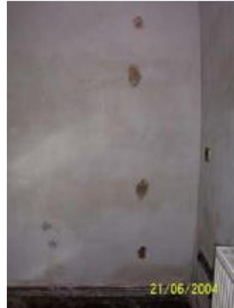
Problemstellung: Extrem starke Putzerstörung und muffiger Geruch im Wohnbereich. Teilweise Bindemittelzerstörung des Sockels im Innenbereich.
