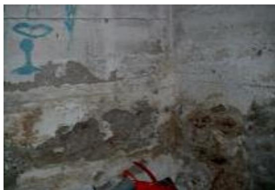
**Ausgangszustand:** Extrem starke Putzerstörung und muffiger Geruch im Kellerbereich. Teilweise Zerstörung der Bindung des Ortbetons. Baujahr 1940
