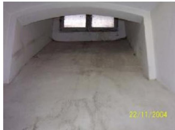
**Problemstellung:** Trotz Sanierung mit Sanierputz deutliche Spuren von Feuchtigkeit und muffiger Geruch im Kellerbereich.
