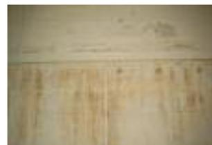
Ausgangszustand: Muffige Luft trotz guter Dauerlüftung. Immer feuchte Kabelschächte. An einigen Stellen Anstrichablösungen, bedingt durch vertikale Undichtigkeiten.
