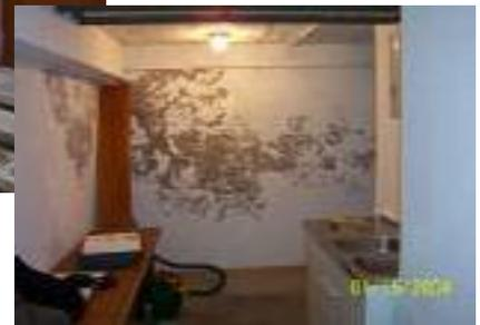
**Ausgangszustand:** Denkmalgeschütztes Gebäude, erbaut in der zweiten Hälfte des 18. Jahrhunderts. Muffiger Geruch im gesamten Kellerbereich und in einigen Bereichen im Erdgeschoß. Trotz Sanierung mit konventioneller Technik (Sanierputz) vor etwa 5 Jahren extrem starke Versalzung, Anstrichlösung und Putzerstörung.
