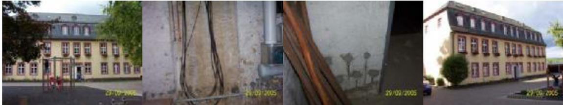
Problemstellung: Bereits saniertes Gebäude mit Vertikalabdichtung Und Chemischer Sperre die nicht funktioniert trockenlegen.
