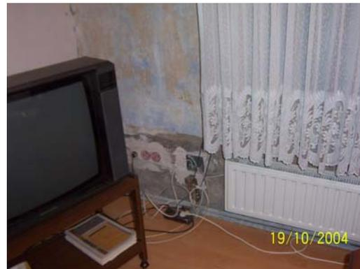
Problemstellung: Extrem starke Putzzerstörung und muffiger Geruch im Wohnbereich. Teilweise Bindemittelzerstörung des Sockels im Innen- und Außenbereich.
