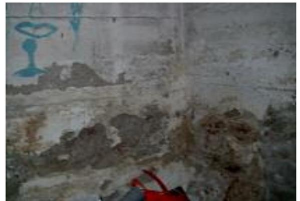
**Ausgangszustand:** Extrem starke Putzerstörung und muffiger Geruch im Kellerbereich. Teilweise Zerstörung der Bindung des Ortbetons. Baujahr 1940
