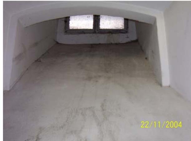
**Problemstellung:** Trotz Sanierung mit Sanierputz deutliche Spuren von Feuchtigkeit und muffiger Geruch im Kellerbereich. Teilweise Bindemittelzerstörung des Sandsteinssockels im Außenbereich.
